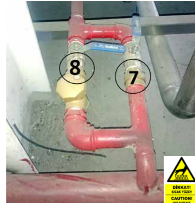
7. Използва се за отстраняване на останалата вода в тръбите.
