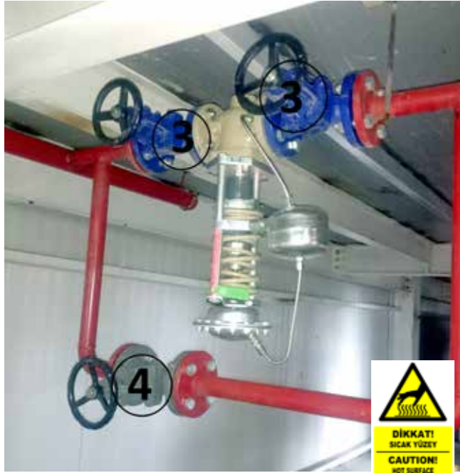
3. Buhar giriş vanaları açılarak, ünite için sabit düzeyde buhar verilir. 4. Üniteye direk buhar vermek için kullanılır.
