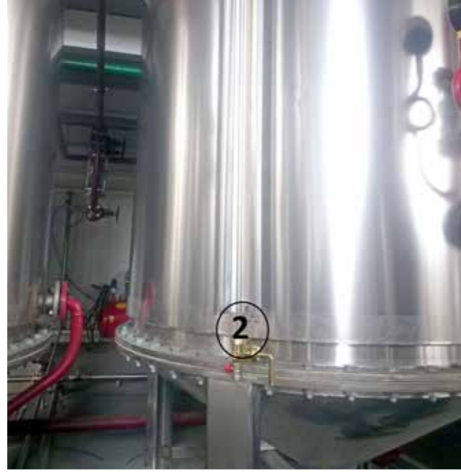
2. Ünite içerisine yeterince su doldurulduğu kontrol edilir.
