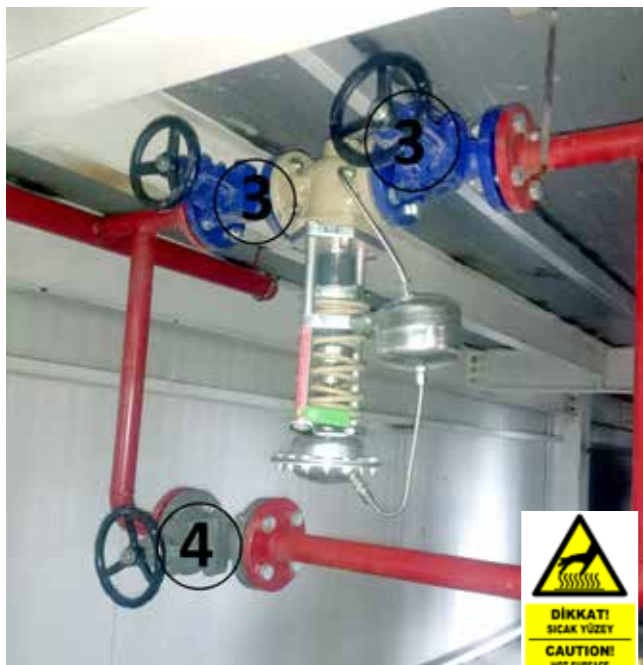
3. парните входящи вентили се отварят и се подава постоянна пара за уреда.
