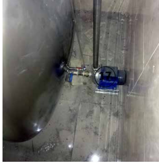
16. Stok tankında birikmiş gülsuyu, pompa ile yağlı su tankına çekilir.
